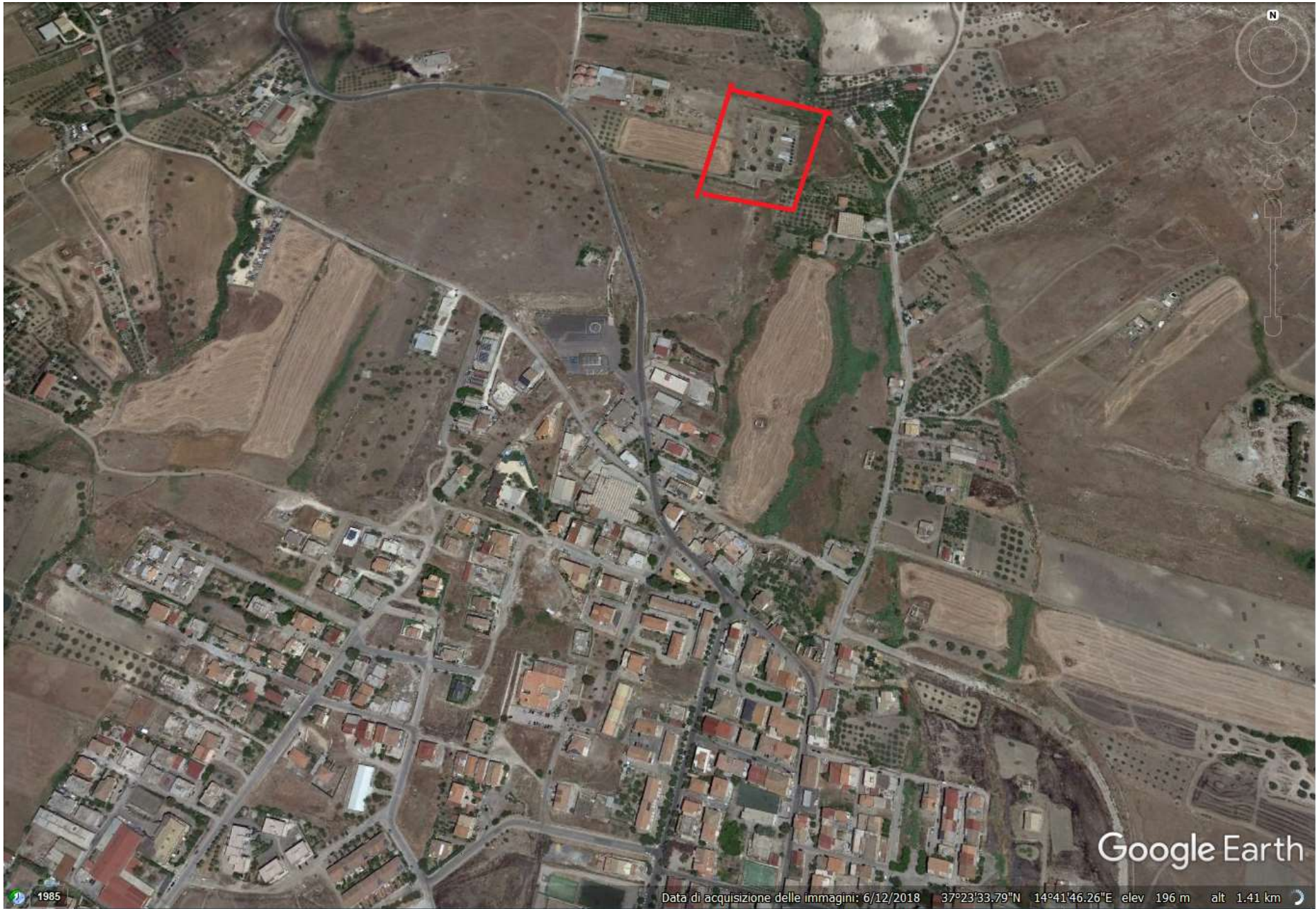
Potenziamento ed adeguamento impianto di depurazione acque nere a Ramacca
