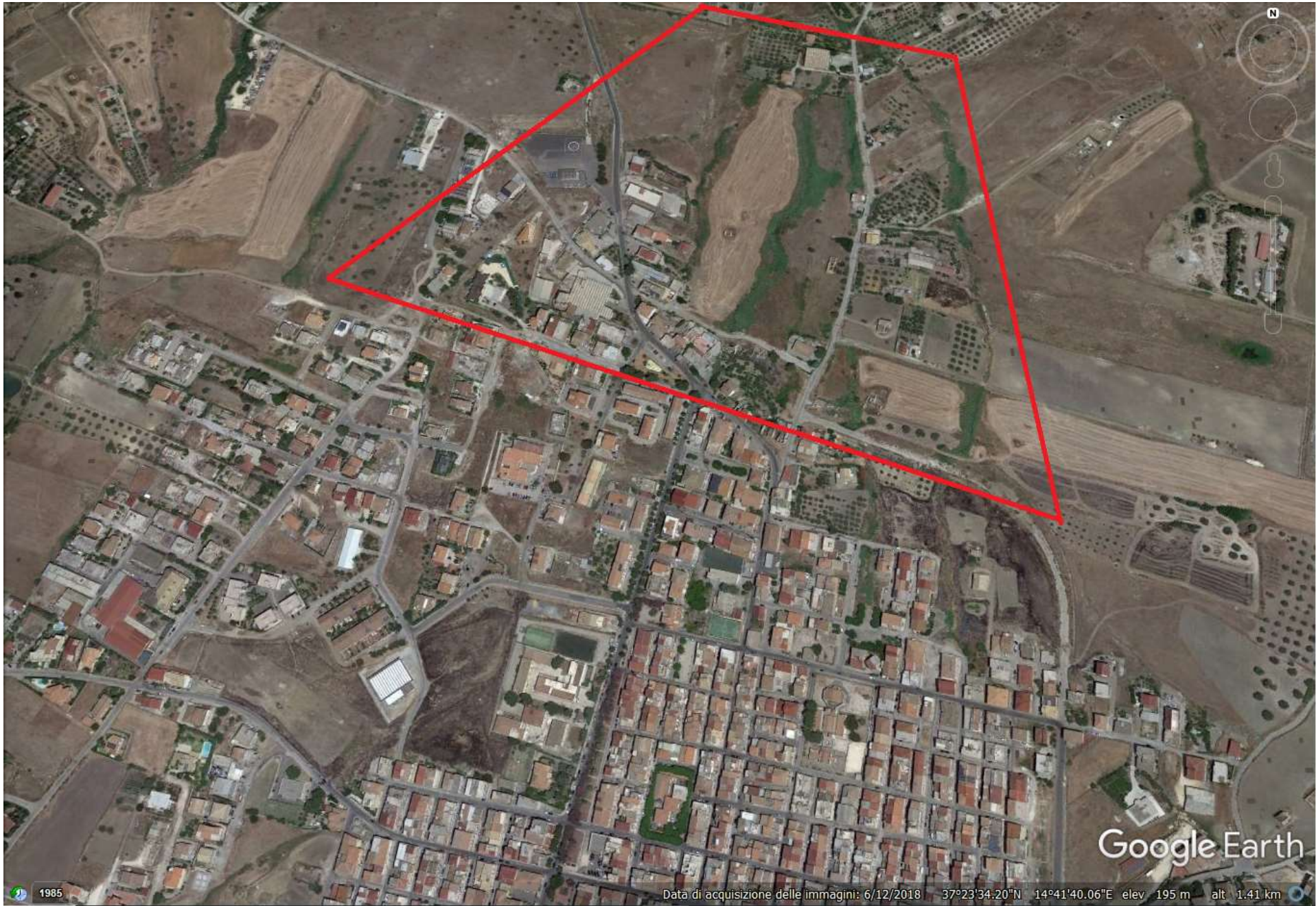
Realizzazione di alcuni tratti di collettori fognari dal depuratore comunale alla rete fognaria urbana
