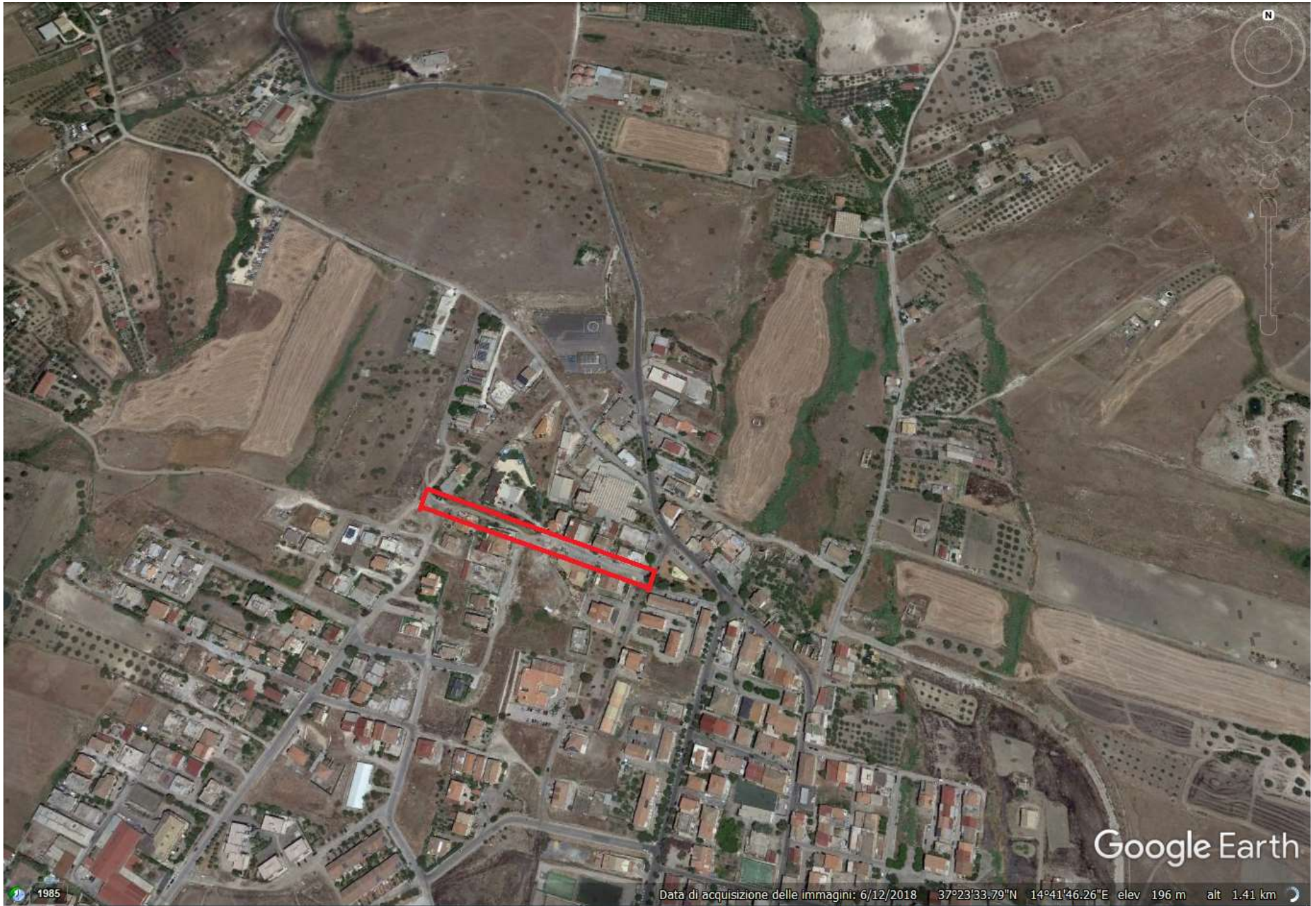
Realizzazione strada di collegamento tra Via Padre Pio e P.zzale G. Fisichella
