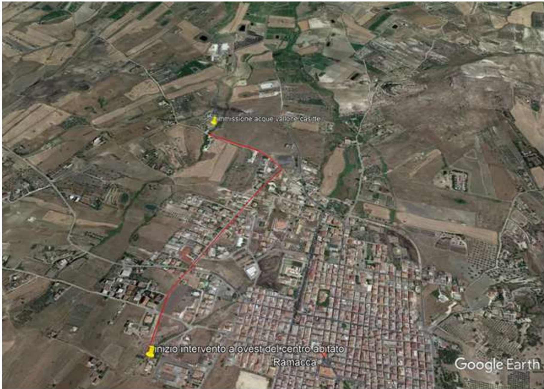
Sistemazione idraulica ed idrologica a ovest del centro abitato, attraverso interventi strutturali sulla rete idrografica e sui versanti
