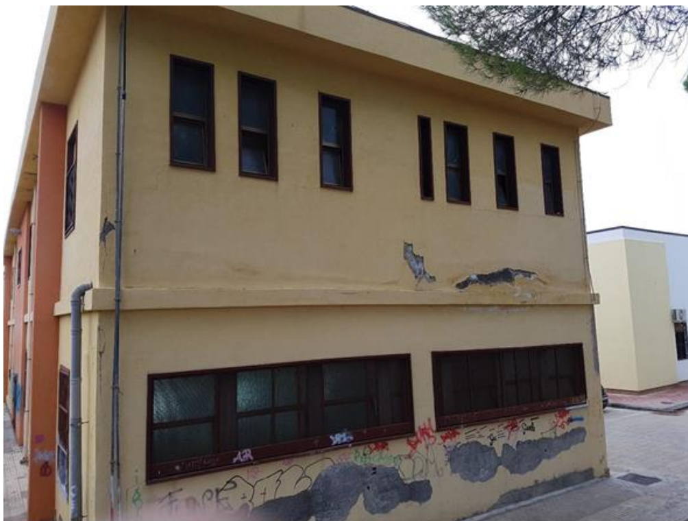
Fig. 6 Prospetto laterale plesso B
