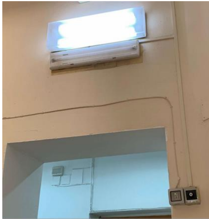
Fig. 16 Corpi illuminanti alogeni vano scala
