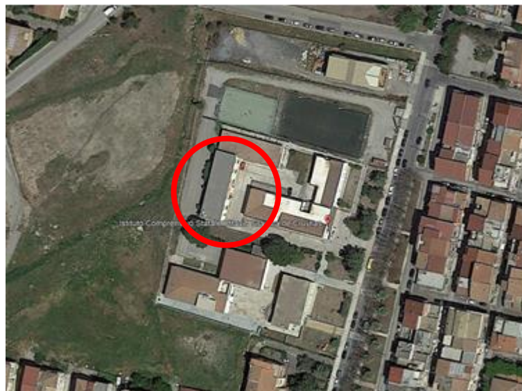
Fig. 1 Ubicazione edificio all’interno del contesto urbano
