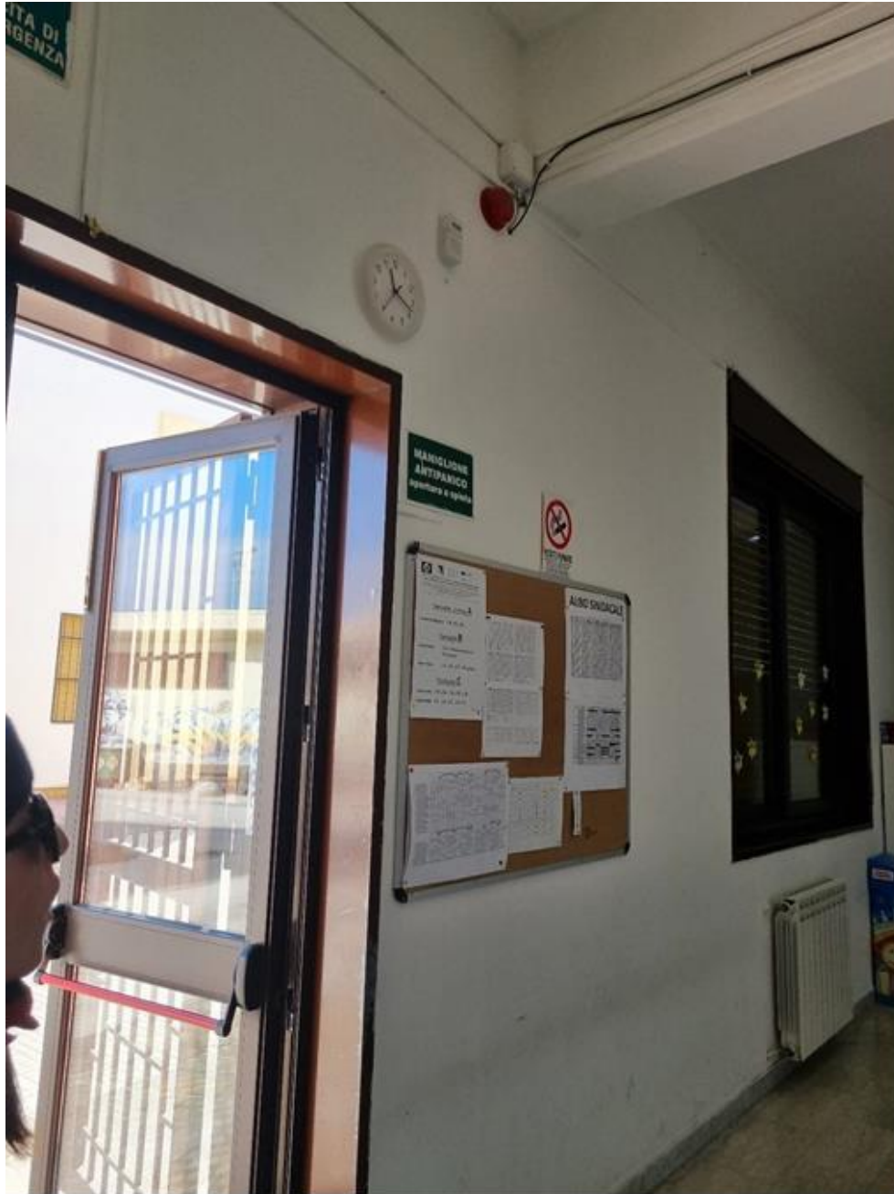
Fig. 9 Corridoio interno su ingresso plesso B
