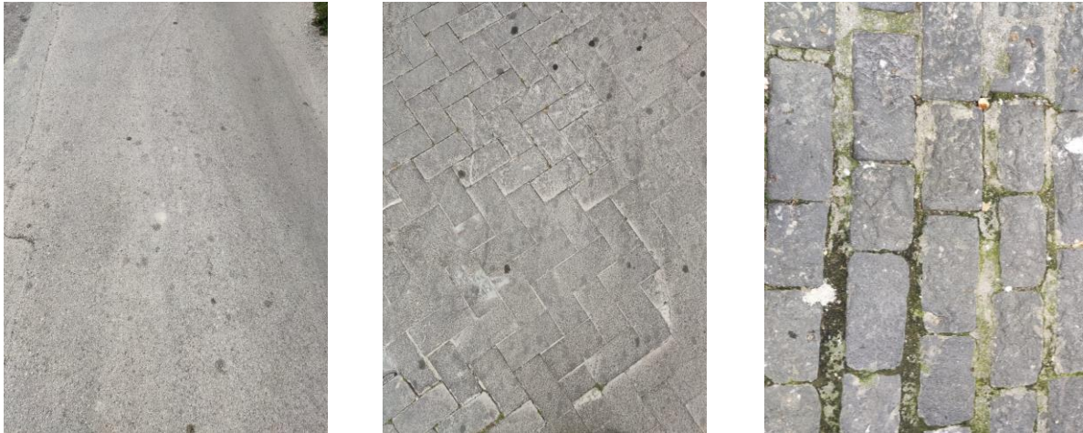
Fig. 3 - Esempi di pavimentazioni esistenti: conglomerato bituminoso, mattonelle in asfalto, bologninato lavico
