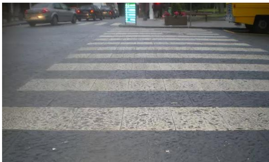
Fig. 7 - Esempio di attraversamento pedonale realizzato mediante basole
