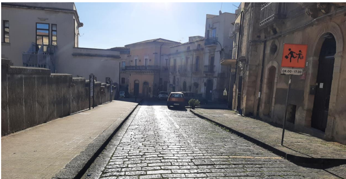
Fig. 4 - Alcune pavimentazioni dei marciapiedi di via Paolo Maura: pietra lavica (lato dx) e pietrine in cemento (lato sx)
