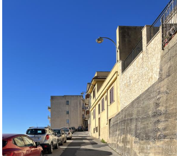
Fig. 5 - Situazione post sostituzione dei corpi illuminanti (via Porticelle)
