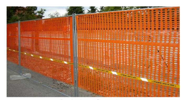
Recinzione di cantiere
